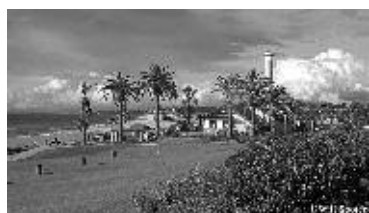
Del Mar Powerhouse
